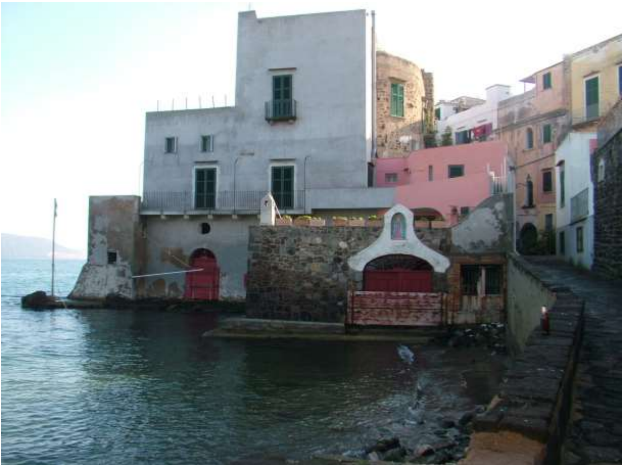
Torre dello Scuopolo a Ischia Ponte
